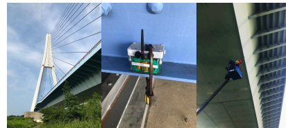
実用展開前の一例の橋梁での設置例 (茨城県)。約1kmの橋梁に対して、44台のセンサを設置し、1つのネットワークとして収容。
