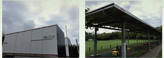
川崎市の公園内に設置されたH2One BCPモデルとバーベキュー設備の屋根に太陽光発電システム(30kW)
